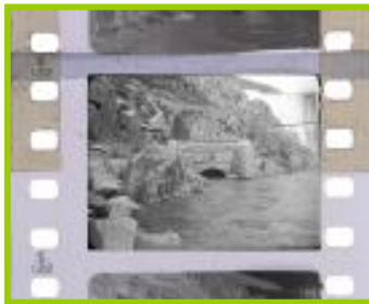
1956 Empalme reforzado con soporte de nitrato
