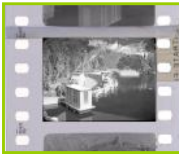
1956 Rotura reparada con soporte de nitrato
